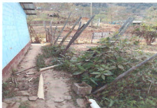
Foto 2: #1. Mejoramiento de Cerco o muro perimetral.
