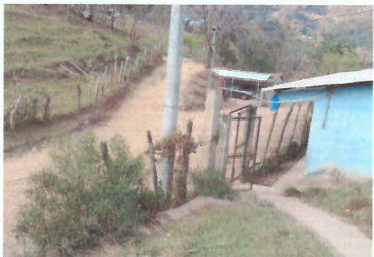
Foto 1: #1. Mejoramiento de Cerco o muro perimetral.
