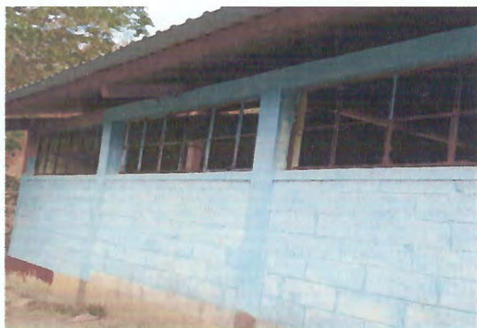
Foto 3: #2. Mejoramiento de Ventanales.
