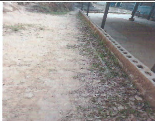
Foto 4: #3. Mejoramiento de Cuneta de concreto.
